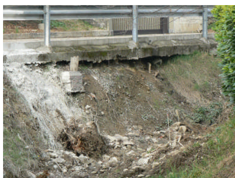
Tratto del torrente di Villa d'Almè prima dell'intervento
