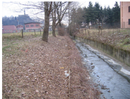
Il torrente Rino dopo il ripristino ad Almè
